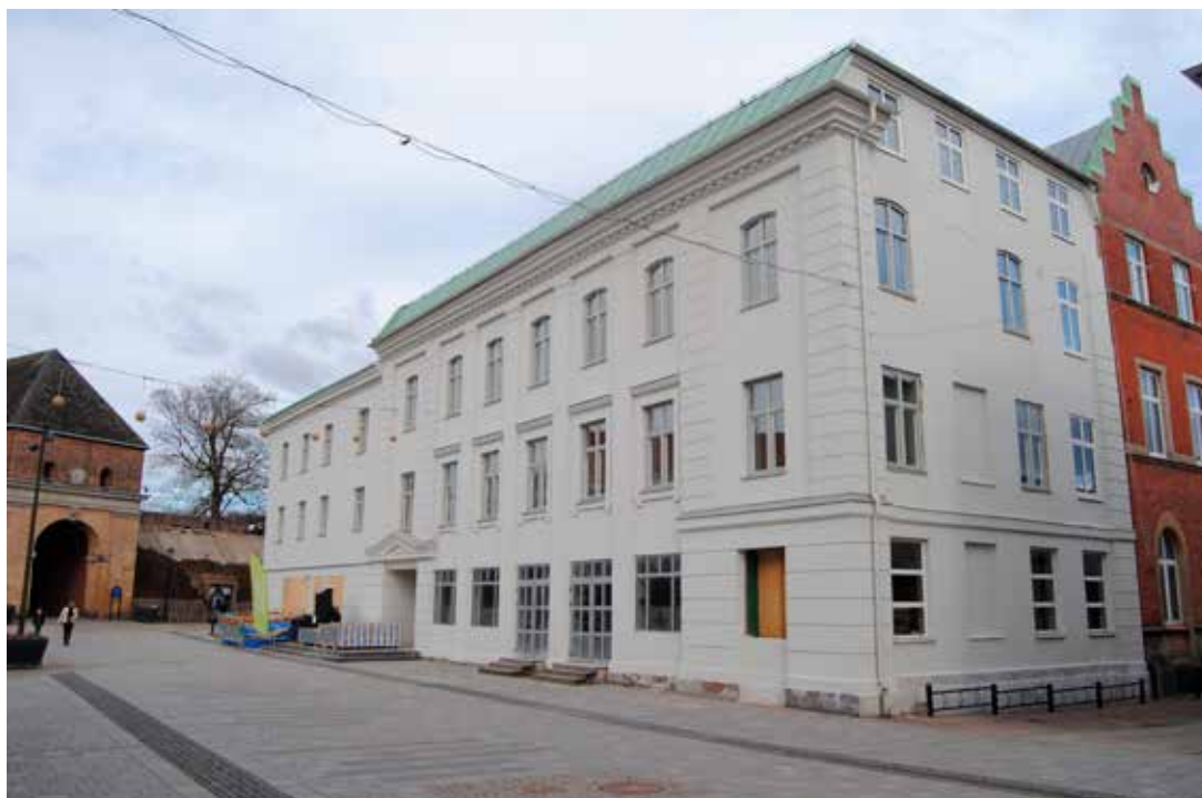
Hotell Mårtensson. Vy från sydväst efter fasadrenovering, mars 2021.
